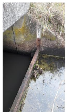
Um die Wasserhöhen und den Abfluss der einzelnen Teilbereiche der Wieken zu regulieren, sind zahlreiche Staustufen (siehe Bild) verbaut. Diese lassen ab einem gewissen Wasserpegel den Abfluss von einem Wiekenabschnitt durch Überlauf in den nächsten Wiekenabschnitt zu.
